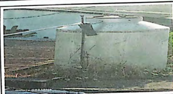
Foto 3: Reparación y cambio de accesorios de tinaco.
