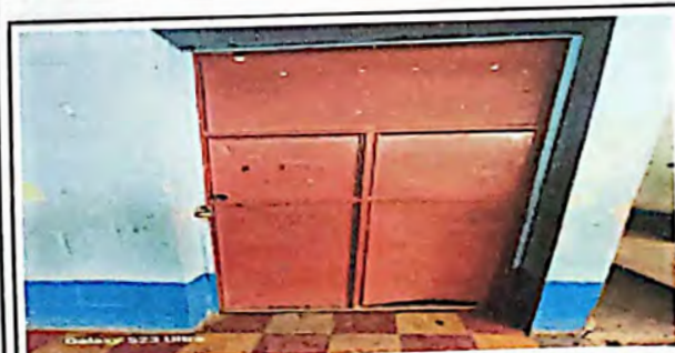
Foto 5: Lijado y pintado de puertas porque la lamina está en mal estado.
