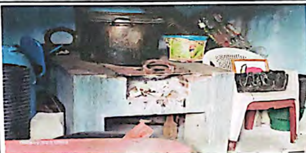
Foto 5: Cambio de hornillas industriales.
