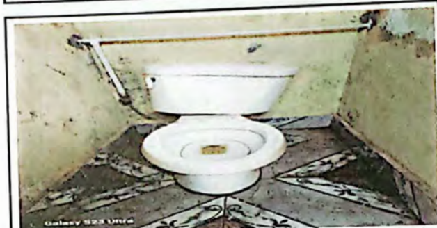
Foto 4: Reparación y pintura de sanitario.
