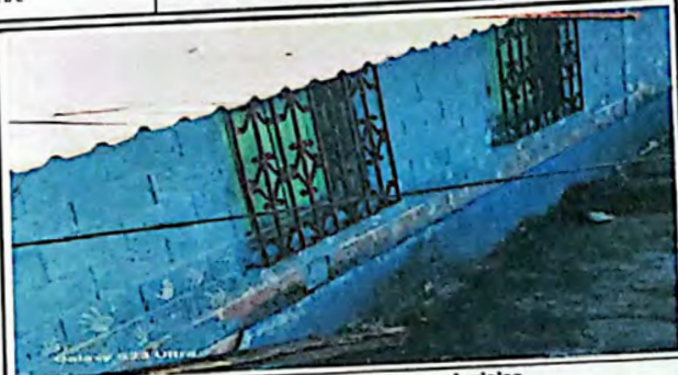
Foto 2: Colocación de canal y tubería de aguas pluviales.
