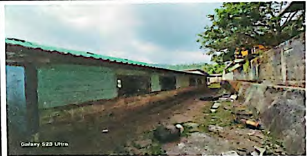
Foto 4: Colocación de canal y tubería de aguas pluviales.
