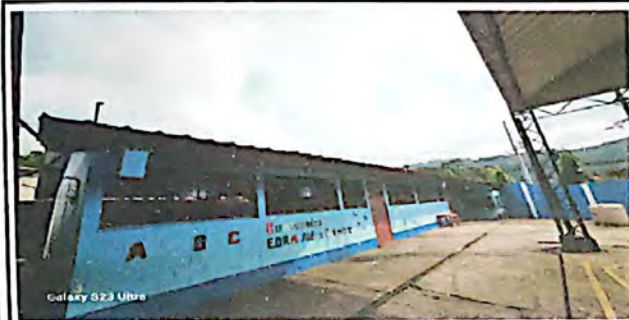
Foto 3: Colocación de canal de caída de agua.
